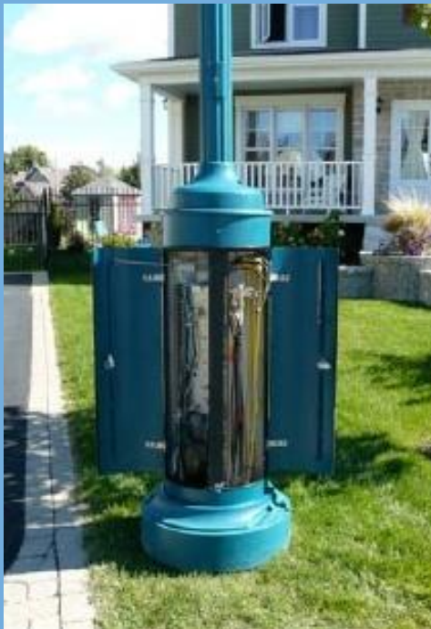
Bornes de raccordement commune Source: MCM intégration
